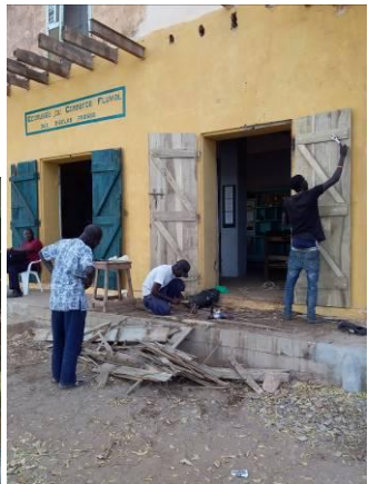
Mahamadou le menuisier change une des portes, trop pourrie !
